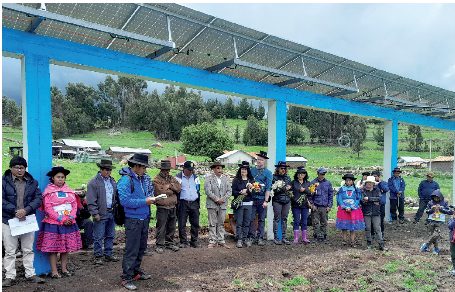
Inauguration du système d'eau devant la structure qui porte les panneaux solaires pour faire fonctionner la pompe d'eau
